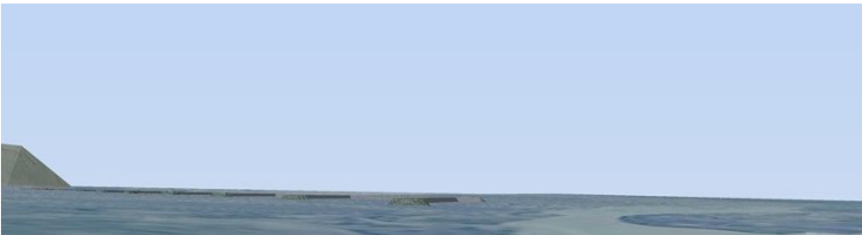
Mynd 2 Múlakvísl – horft á varnargarða í farvegi (mynd 11.7 í skýrslu)
