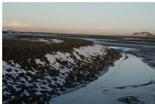
Mynd 7.2 Varnargarðar við brú á Markarfljót áþekkir þeim sem byggður verður í árfarvegi.
