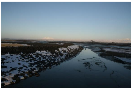
Mynd 7.2 Varnargarðar við brú á Markarfljót áþekkir þeim sem byggður verður í árfarvegi.
